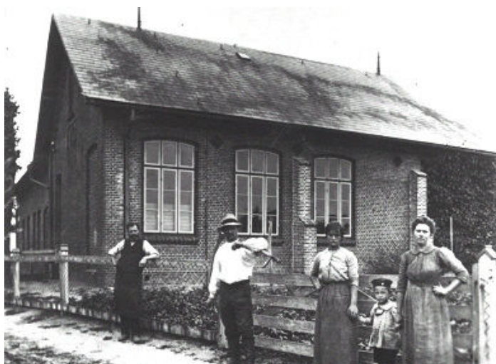
Die 1914 aus dem alten Schulgebäude erbaute Turnhalle.
